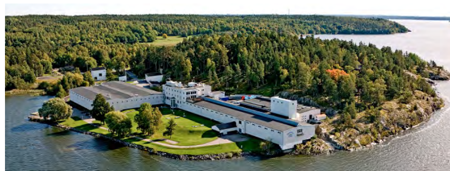
Figur 1. Görvälns vattenverk. Foto: Norrvatten AB.
