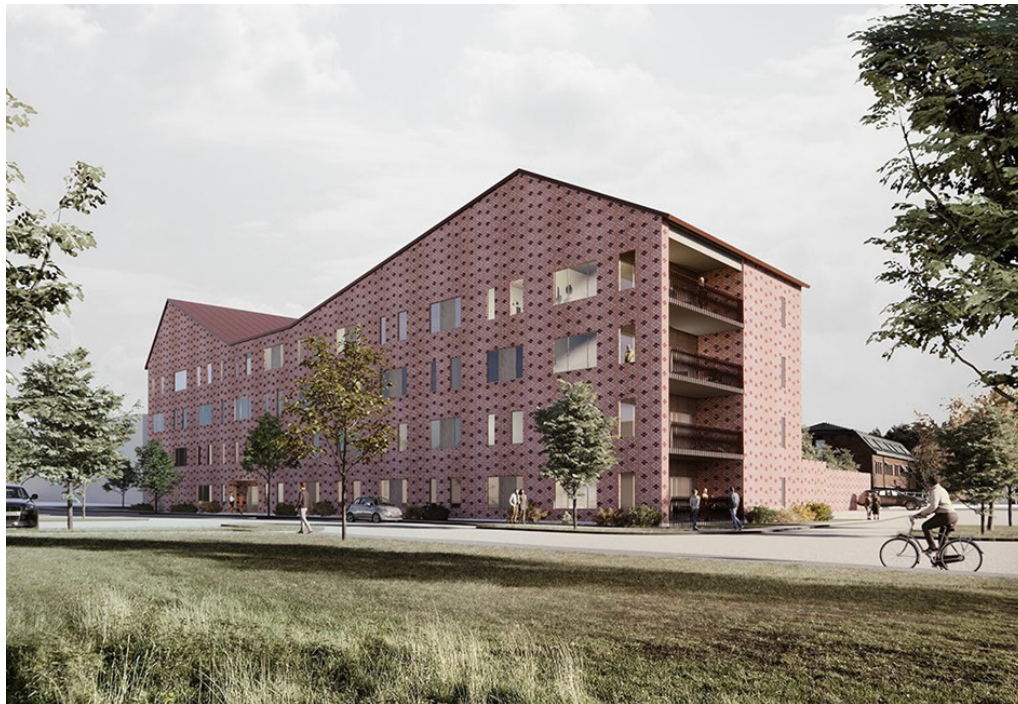
Bild 8 Vård- och omsorgsboendet sett från nordväst, norr om Sportfältsvägen (bild: Marge arkitekter)
