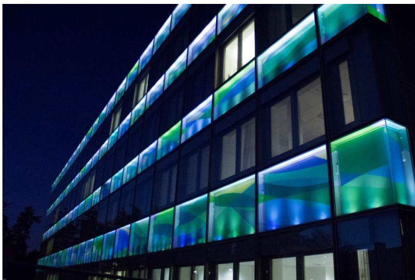
Exempelbild konst. Screenshot tryckt glas och betong med inbyggd belysning. The color of water av Spencer Finch för Universitetssjukhuset i Linköping. Beställare Region Östergötland. Projektledning konst AM Public. Foto Johan Jäger.
