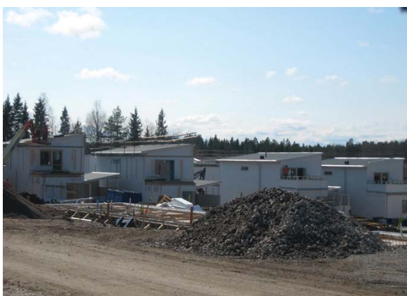
Vretalund under uppbyggnad.
