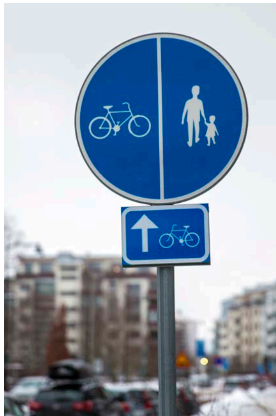
Kompletterande färdriktningsanvisning utmed Muningatan i Kungsängen för att påvisa rekommenderad enkelriktning av cykelbana.
