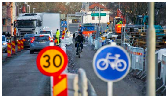
Exempel på trafikomledning vid pågående gatuombyggnad.
