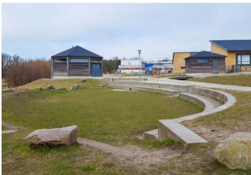
Figur 38. Exempel på multifunktionell yta där dagvatten vid skyfall tillfälligt fördröjs. Under större delen av året används platsen som lektyta. Källa: Haninge kommun
