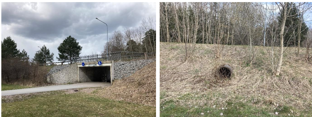
Figur 16. Till vänster: Kupolbrunnar i anslutning till GC-porten under Elfrida Andréés väg. Till höger: Trumma under Elfrida Andréés väg. Foto: WSP (2021).
