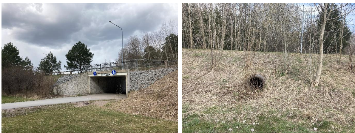
Figur 14. Till vänster: Kupolbrunnar i anslutning till GC-porten under Elfrida Andréés väg. Till höger: Trumma under Elfrida Andréés väg. Foto: WSP (2021).
