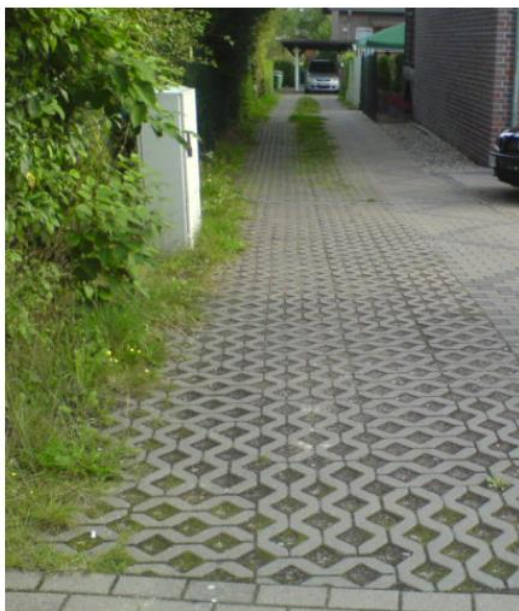
Figur 24. Till vänster: Exempel på gräsarmerad betongbeläggning. Till höger: Principskiss för genomsläpplig beläggning (Stockholm Vatten och Avfall, 2017c).
