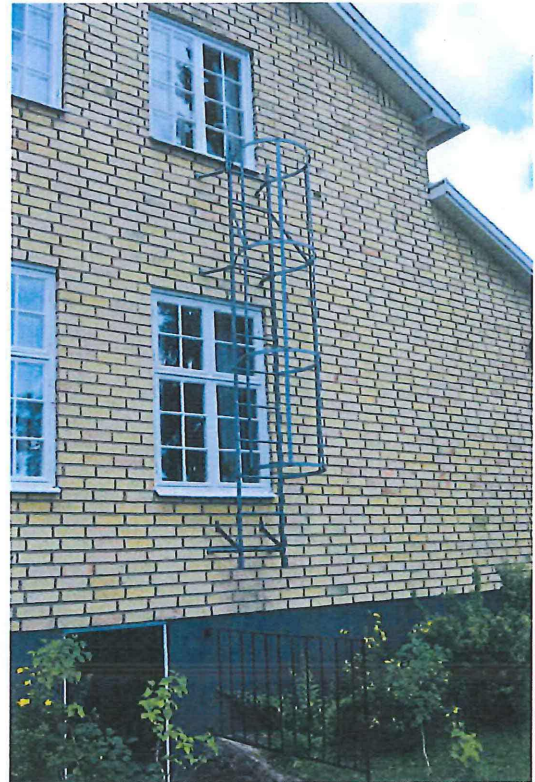
Utrymningsväg från mötesrummet
