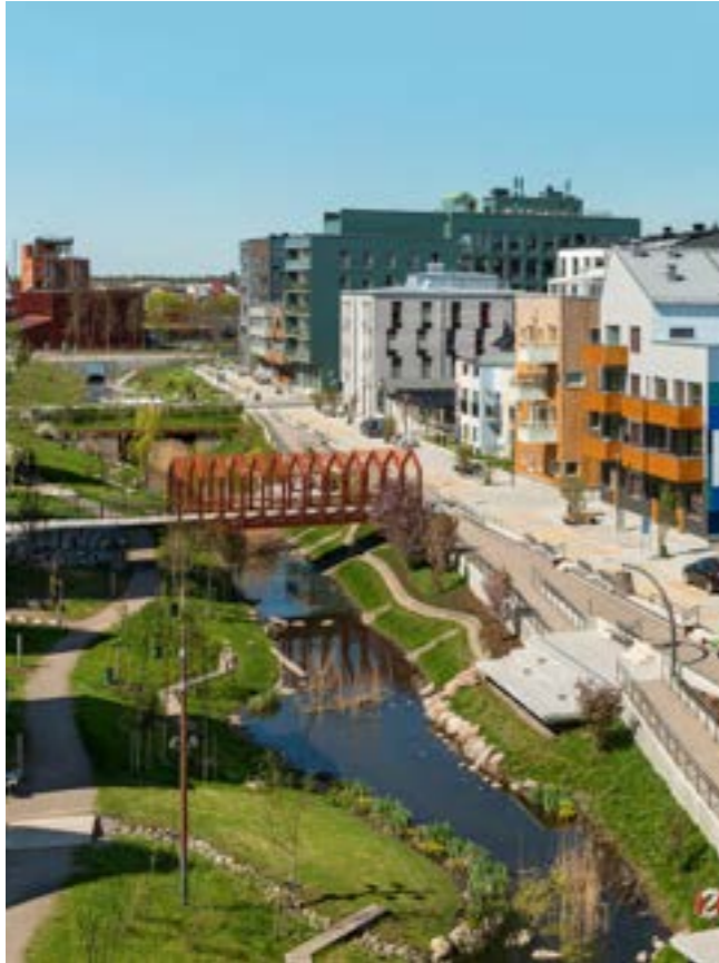
Ett nytt kombinerat park- och gaturum kring dagvattendammar utvecklas i nordvästra campus mellan det nya stråket och Veterinärvägen. Genomfartstrafiken sker på fotgängarnas villkor. Broparken Vallastaden, White arkitekter.
