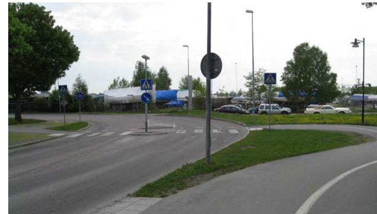
Östra Ågatan anslutning till Kungsängesplanaden, nuvarande utformning (Foto Bjerking AB)
