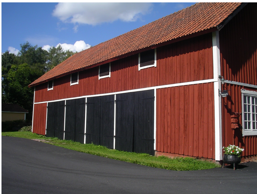
Ekonomibyggnad med inslag av svart i färgsättningen. Svart är en återkommande färg på flera platser i byn.
