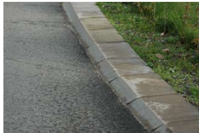
Betongkantsten markerar gräns mellan gata, gångväg och trädplantering
