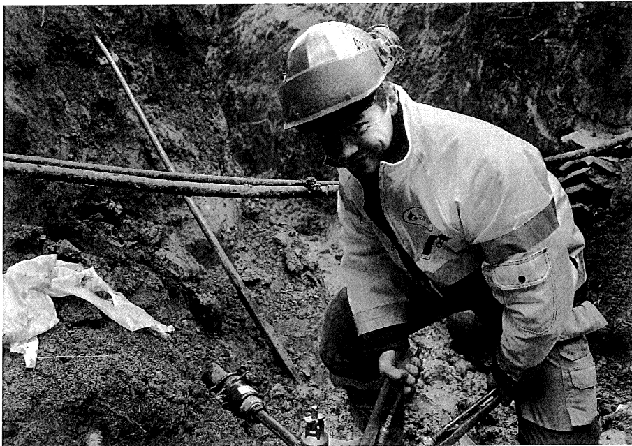
Påkoppling av vattenledning mellan Uppsala och Gunsta
