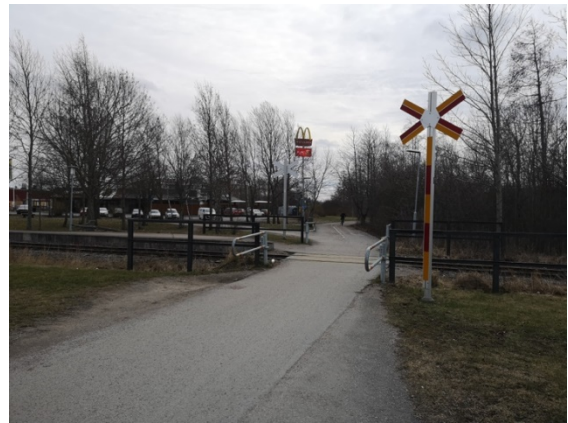
Vy från norr, passage.
