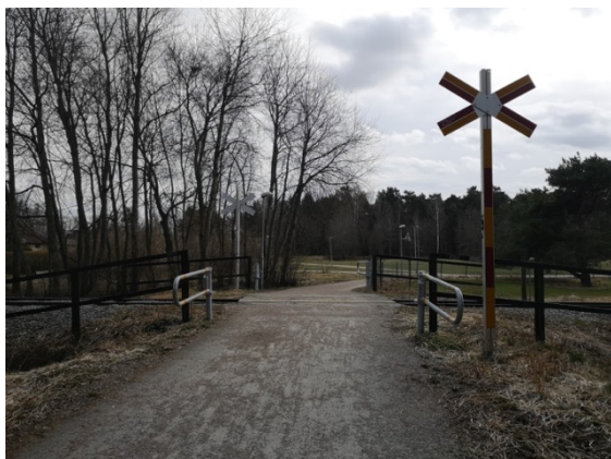
Vy från norr, passage.
