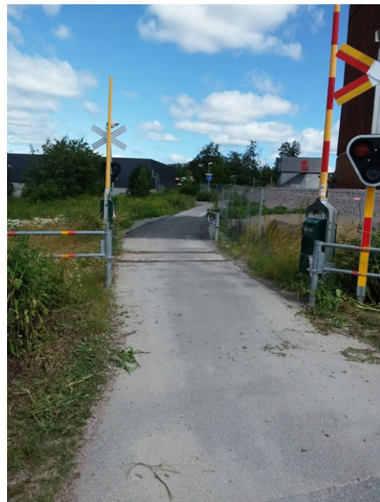
Gång- och cykelpassage Vattenfall, Boländerna.
