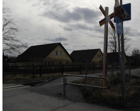
Perrongen ansluter till passagen mellan gångfällan och spåret.
