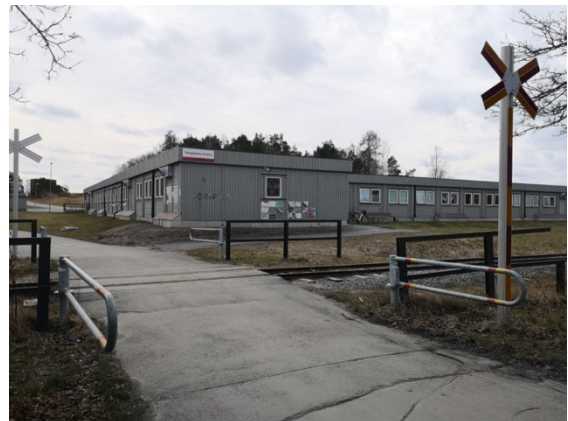
Vy från norr, passage.
