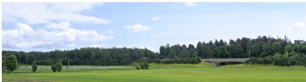
Bild 54. Fotomontage som visar korsningen med Hemslöjdsvägen. Hemslöjdsvägen sänks och går under kollektivtrafiken i en viadukt. På bilden syns också den tillkommande vegetationen som omger bron och bankarna. Bild: Bjerking och Rundquist arkitekter.
