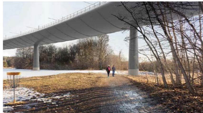
Figur 13.. Fotomontage som visar broalternativ med 16 meter segelfri höjd. Utblick söder ut från Ultuna källväg, strax norr om bron. Bron fortsätter i vänster på bilden ut över Fyrisån. Bild av Rundquist arkitekter.
