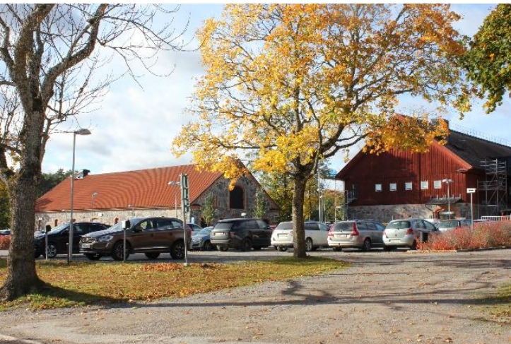
Figur 14 - Bevarade ladugårdar och ekonomibygnader.
