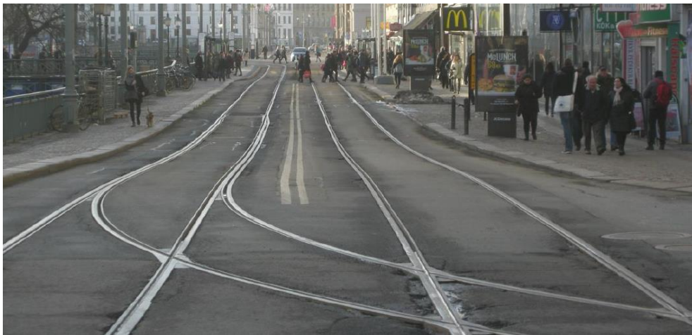
Figur 30 Exempel på förtungad växel för att klara avgrening i vertikalradie. Foto: Stig Hammarson
