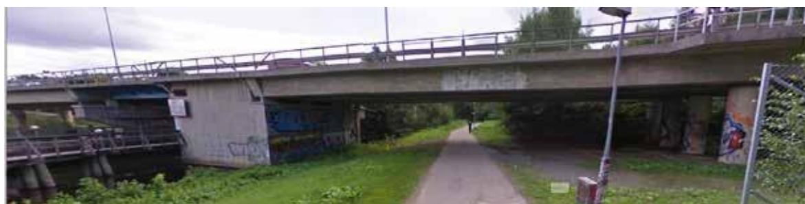
Kungsängsbron är en öppningsbar bro för biltrafik och har en fri höjd på 3,5 m över gångstråk. Utöver konstruktionshöjden tillkommer räcken och belysningsstolpar. För spårbron gäller motsvarande där tillkommer räcken och kontaktledningsstolpar.
