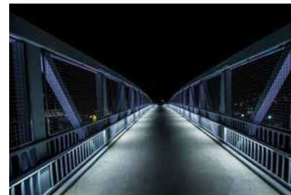
Ljussättning i räcke: G&G Industrial Lighting
