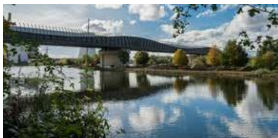
Exempel där man med hjälp av räcken försökt dölja spårvagnens rörelse i landskapet Neckar Valley Bridge, Heilbronn.
