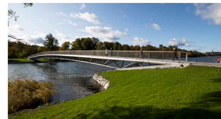
Referensbild: modellerade slanter med dolda landfästen.
