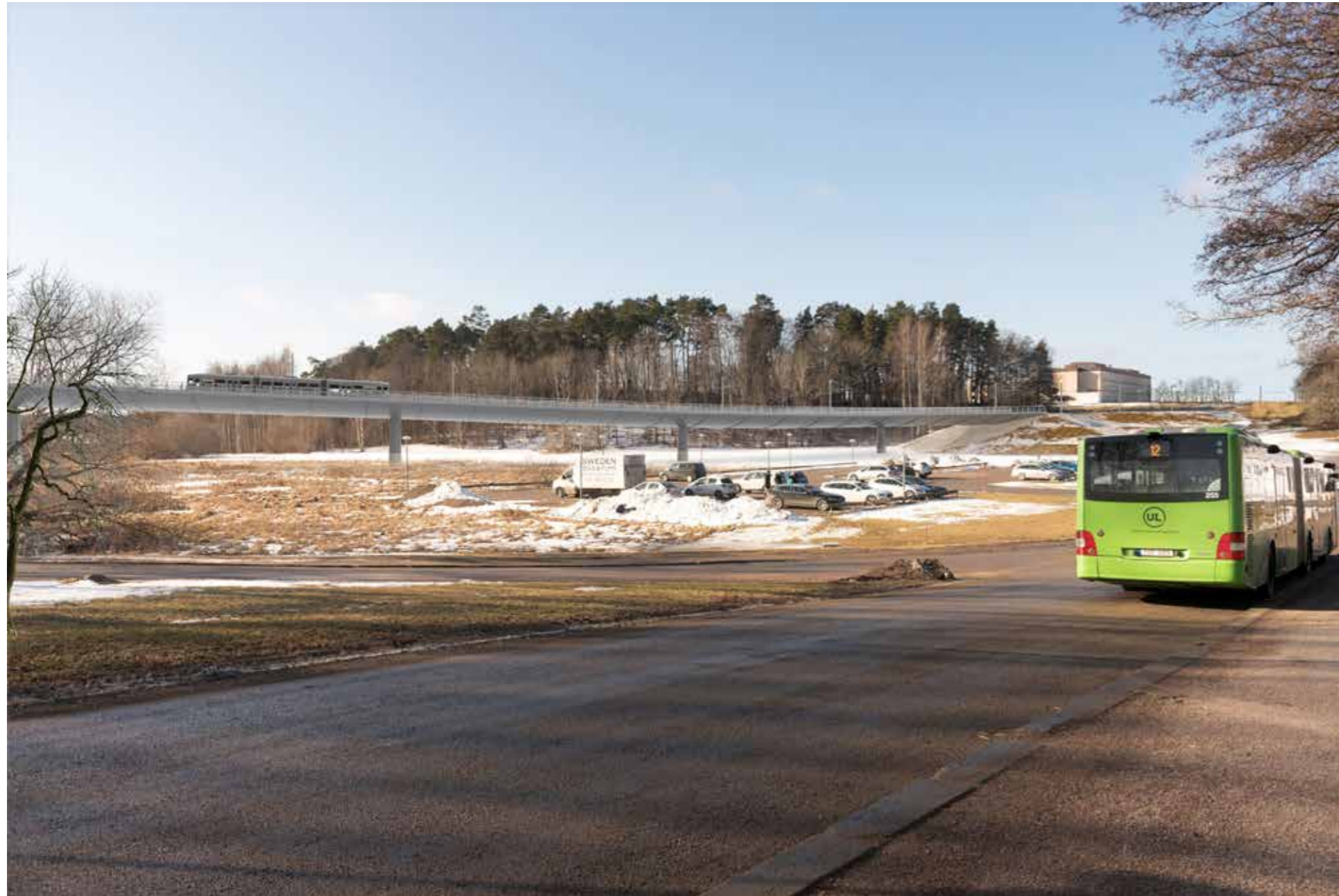
Utblick mot sydväst från korsningen Ultunaallén och Ultuna källväg, norr om utbyggnaden. Till höger syns anslutning till mark med landfästet dold i bank. Från den här vypunkten när alternativen närmast identiska.
