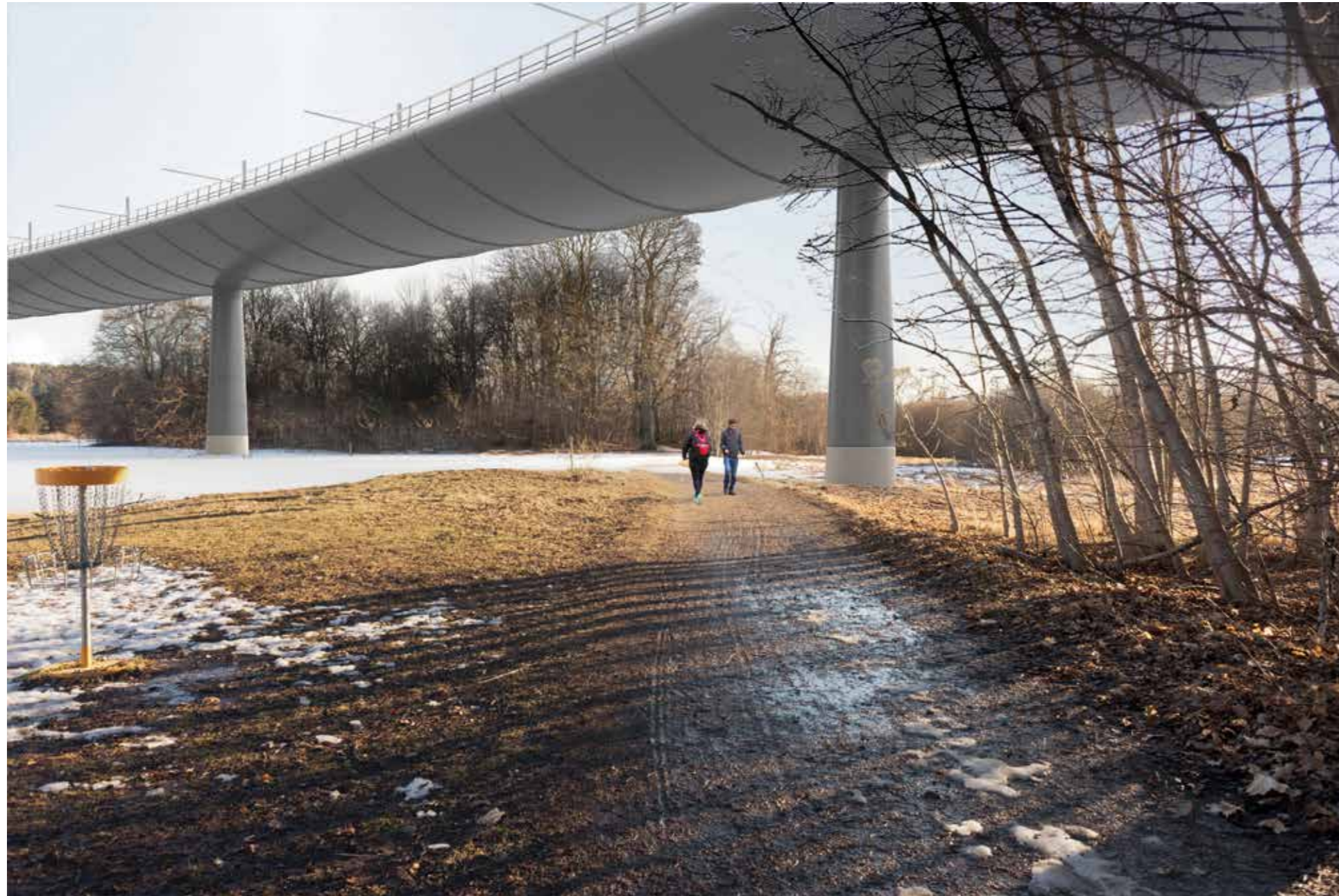
Utblick söderut från Ultuna källväg, strax norr om bron. Till vänster i bild syns bron passera befintlig aldunge varefter den fortsätter mot passage över Fyrisån, utanför detta bild. Frihöjden under bron är ca 12 m.
