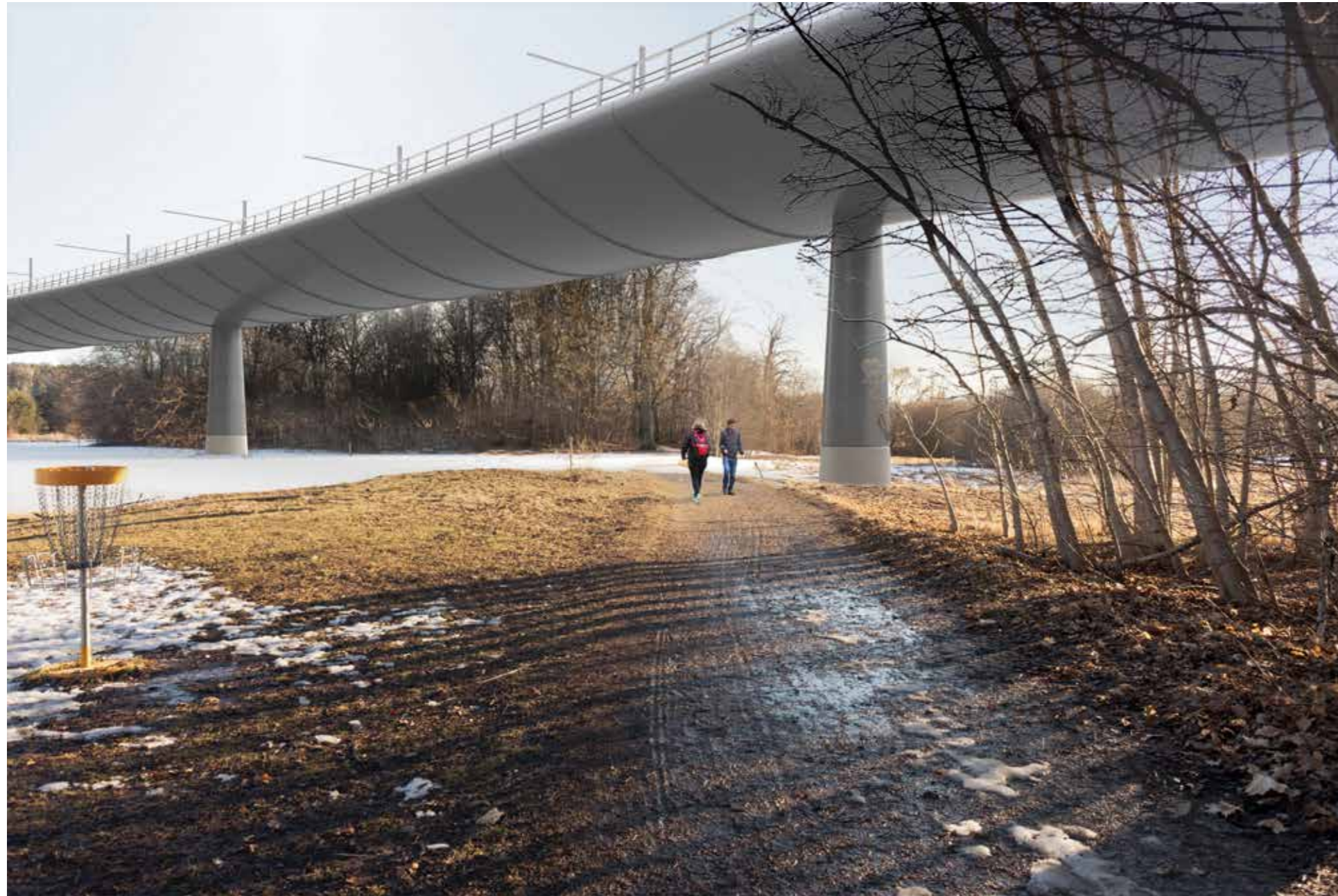
Utblick söderut från Ultuna källväg, strax norr om bron. Till vänster i bild syns bron passera befintlig aldunge varefter den fortsätter mot passage över Fyrisån, utanför detta bild. Frihöjden under bron är ca 10 m.
