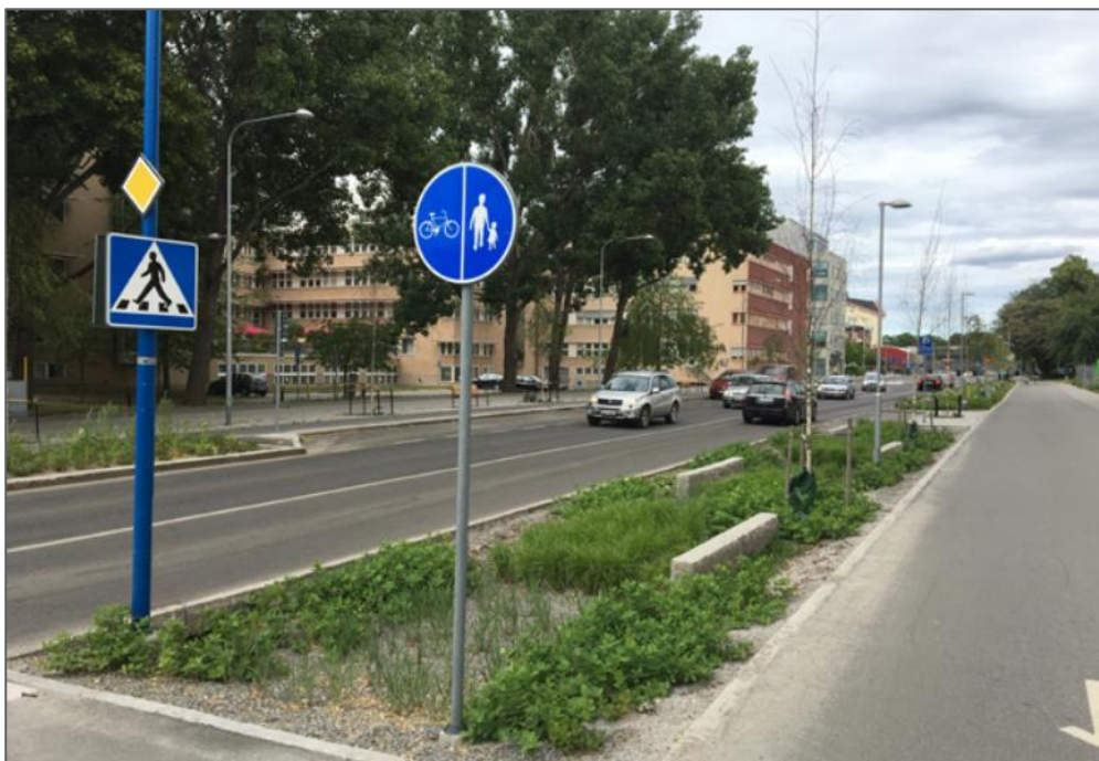
Figur 21. Exempel av regnbädd på stråk av öppet förstärkningslager, Strandbogatan i Uppsala. Bild: (Uppsala kommun, 2020)
