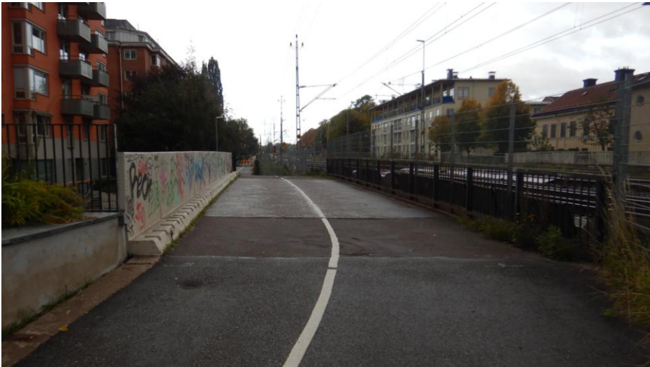
Figur 3.26, gång- och cykelväg över bro 3500-3728-2. Foto: BaTMan.
