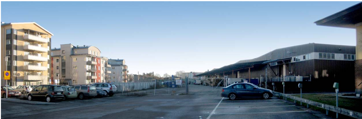
Det gamla industrispårområdet mellan kv Klockaren och kv Gimo, sett från Fyrisvallsgatan.
