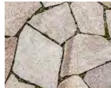
Naturstenshällar i ett oregelbundet mönster utgör golvet i den större samlingsplatsen.
