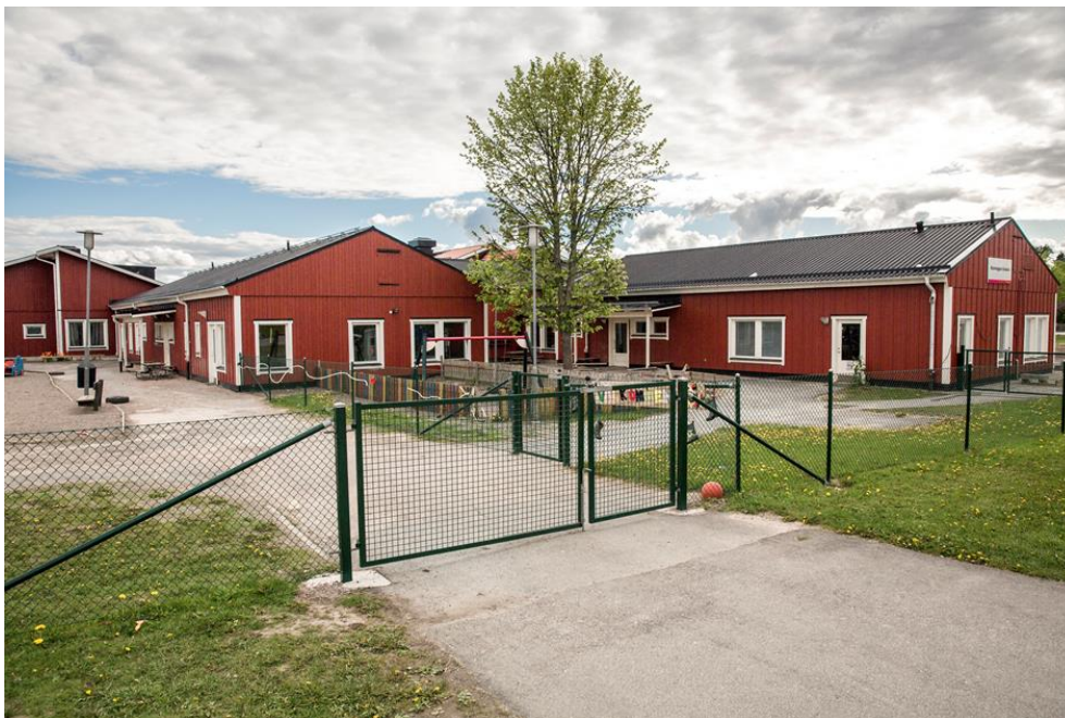
Malmvågens förskola har renoverats och byggts till samtidigt som utemiljön rustats upp
