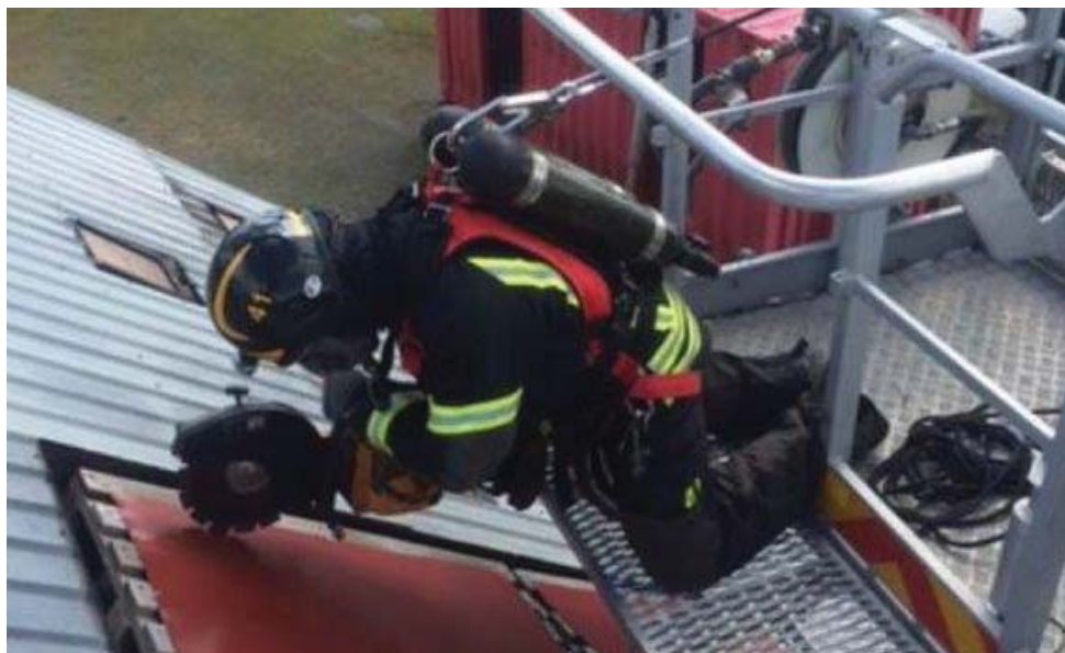
Övning av håltagning i tak med motorsåg.
