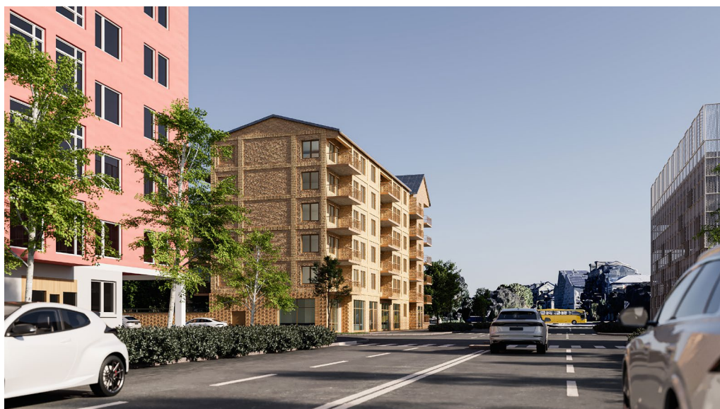
Figur 8. Vy av kvarteret sett från Råbyvägen söder om planområdet. Gestaltning av bottenvåning, samt tegelbehandlingen i kvarterets olika delar syns i bilden (bild: Archus).
