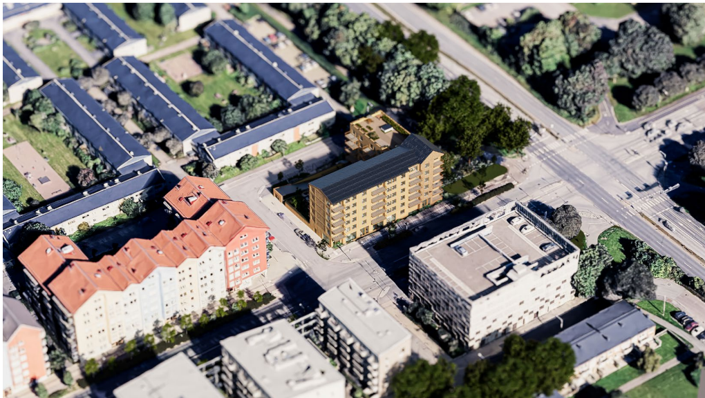
Figur 1. Flygvy av kvarteret sett från söder. Kvarteret syns i mitten av bilden (bild: Archus).
