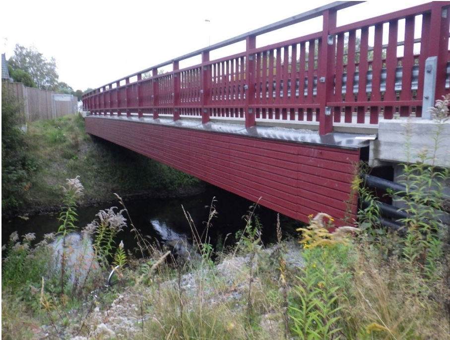
Figur 2. Exempel: Bro över Nossan NV Herrljunga, spännvidd 22,9 meter (bild från BaTMan).
