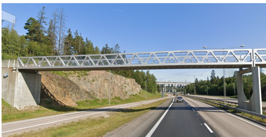
Figur 6. Exempel: bro över E4 Södertälje i rostfritt stål (bild från Google).
