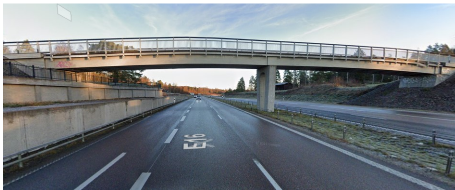
Figur 3. Exempel: bro över väg 50 i Falun, spännvidd 24,5+24,5 meter (bild från Google).
