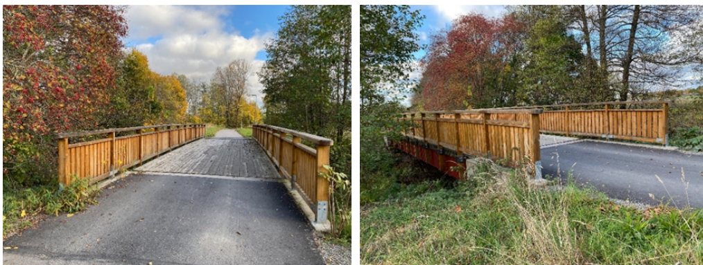
Bild 19 Exempel på en låg gång-och cykelbro i trä utan stödben. Bron ligger längs med Fyrisån öster om Librobäck.
