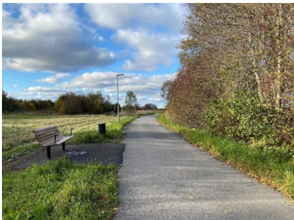
Bild 16 Exempel på utformning av gång- och cykelväg. Bilden visar gång- och cykelvägen längs med Fyrisån mellan Svartbäcken och Librobäck som är asfalterad med belysning, sittbänkar och soptunnor finns längs med vägen.
