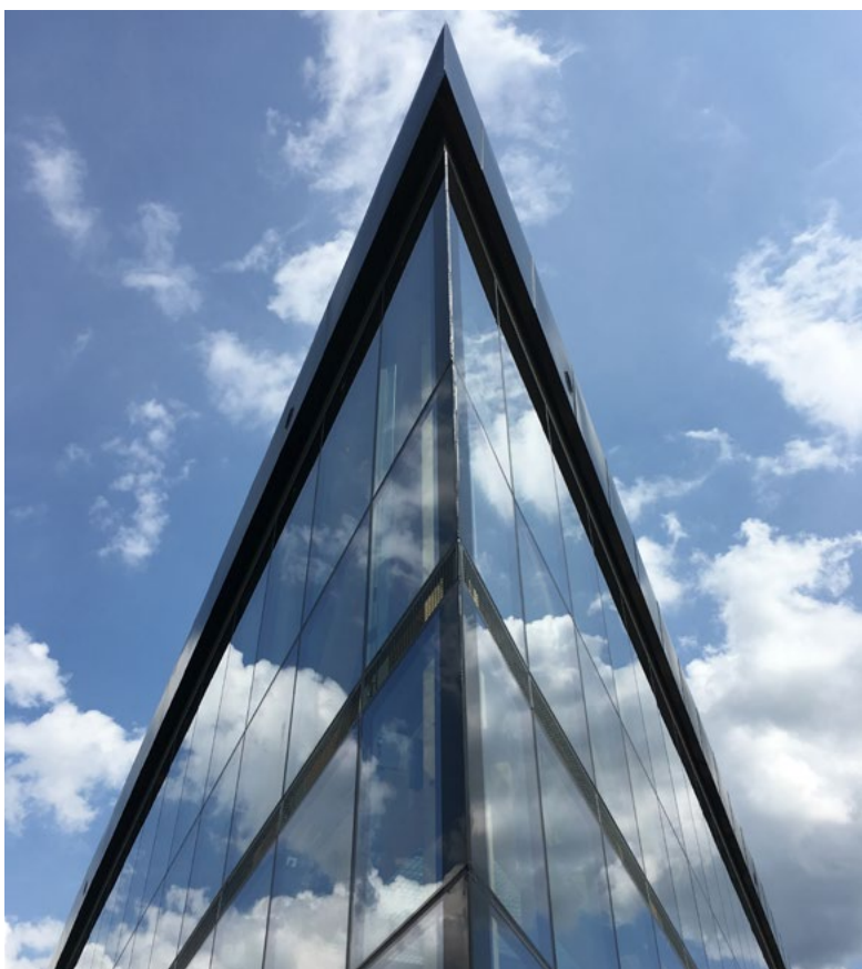
Cykelparkeringshusets fasad mot Stadshusgatan vid Resecentrum i Uppsala.
