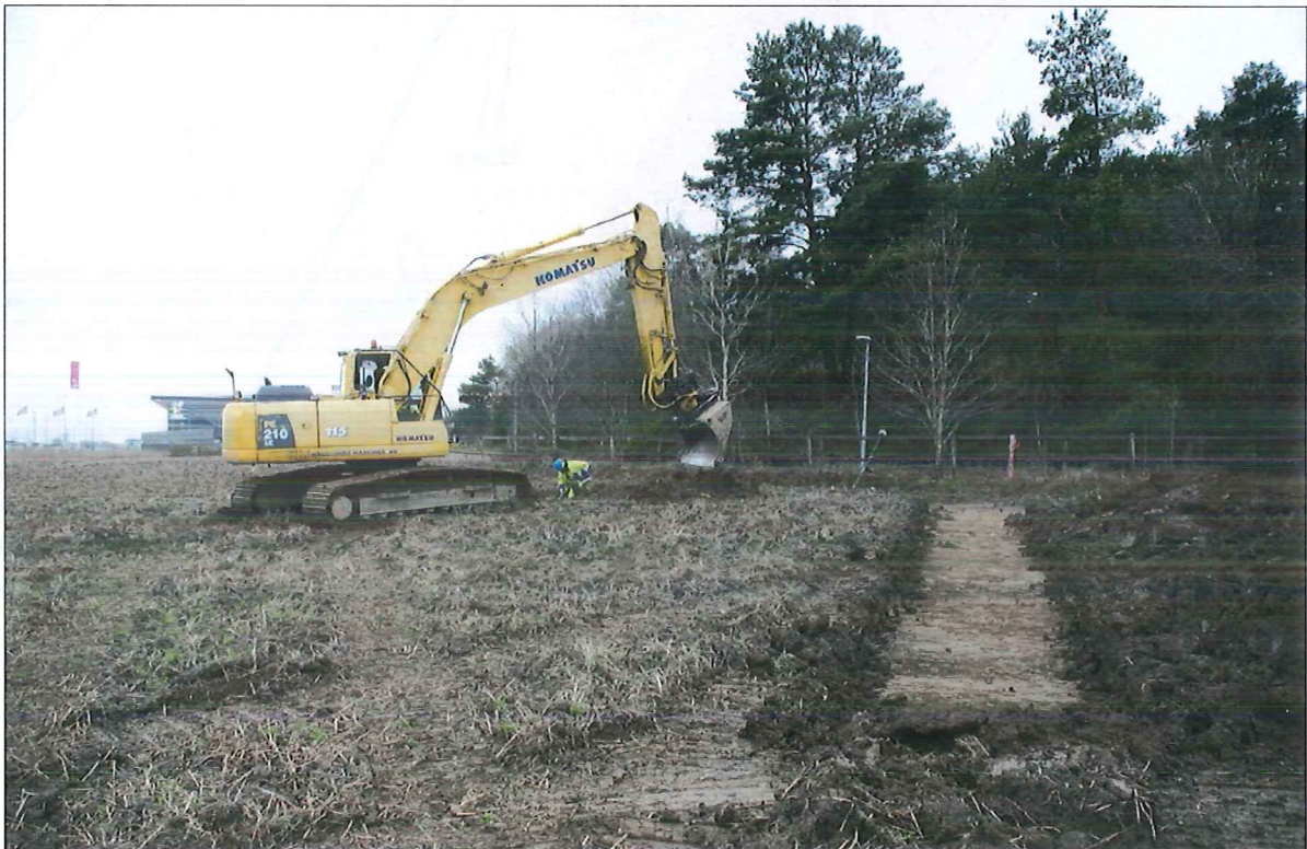
Figur 6. Maskin och arkeolog i arbete i området där nya förhistoriska lämningar påträffades. Foto från norr: Magnus Lindberg.
