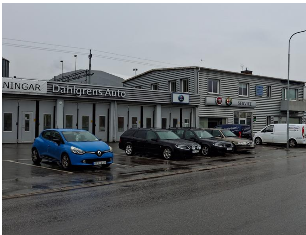
Figur 26. Byggnad på Kungsängen 36:1 som avses att rivas.
