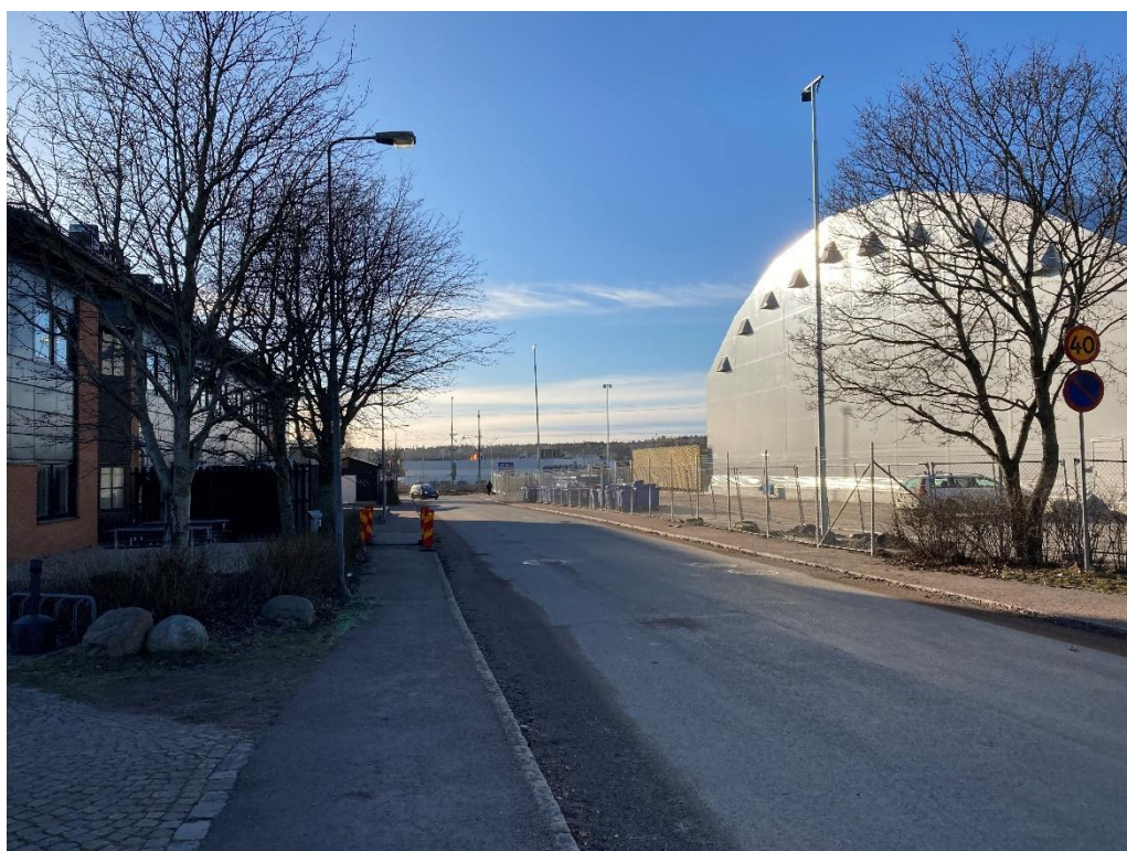
Figur 12. Kungsängsvägen i södergående riktning. På fastigheten Boländerna 22:7 (till höger) står ett tält uppfört med ett tidsbegränsat bygglov.
