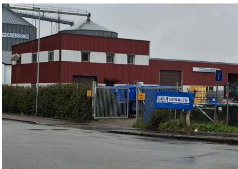
Figur 28. Byggnad på Boländerna 16:8.
