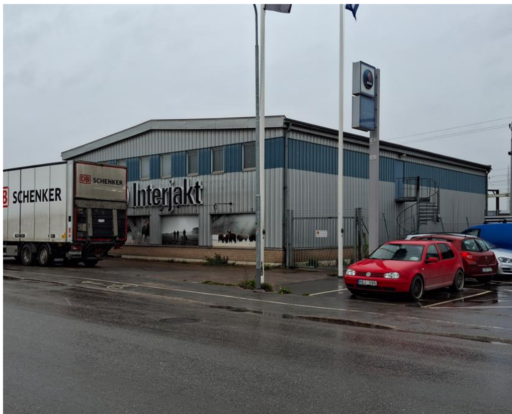
Figur 27. Byggnad på Kungsängen 36:3 vilken delvis kommer att rivas.
