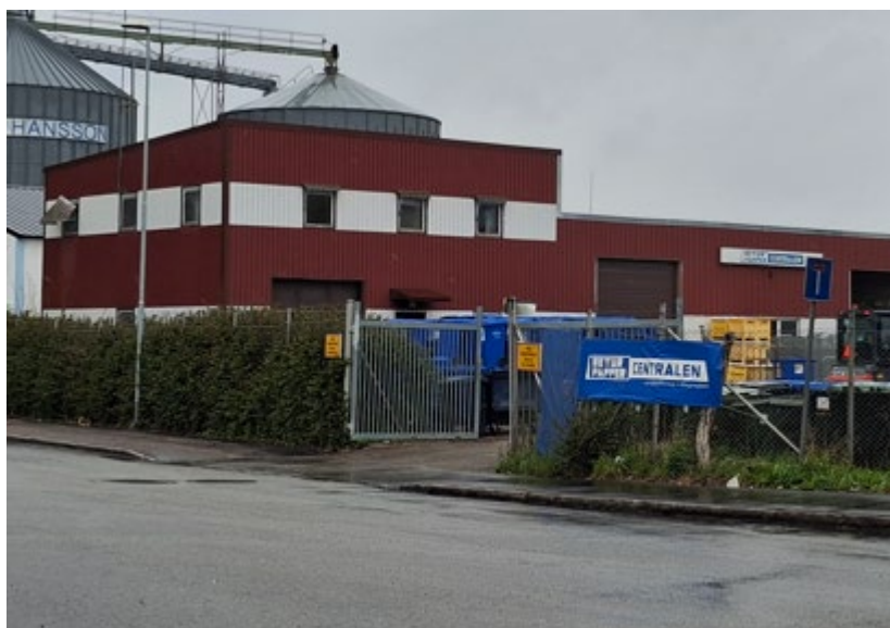
Figur 31. Byggnad på Boländerna 16:8 som avses att rivas.
