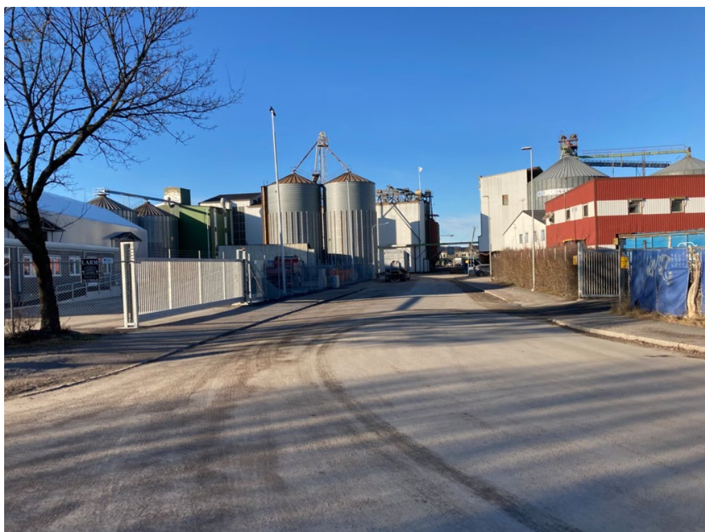
Figur 14. Villingegatan i norrgående riktning.
