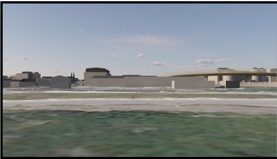
Figur 8-7. Vy 3. Utblick in mot Uppsala. Härifrån ses stadens siluett med Domkyrkan i periferin till vänster i bild. Förslag på ny betongbro över järnvägen ses till höger i bild. Från denna vy upplevs bron vara överordnad bebyggelsen. Betongbron dominerar i stadsbilden (Sweco, 2025a).
