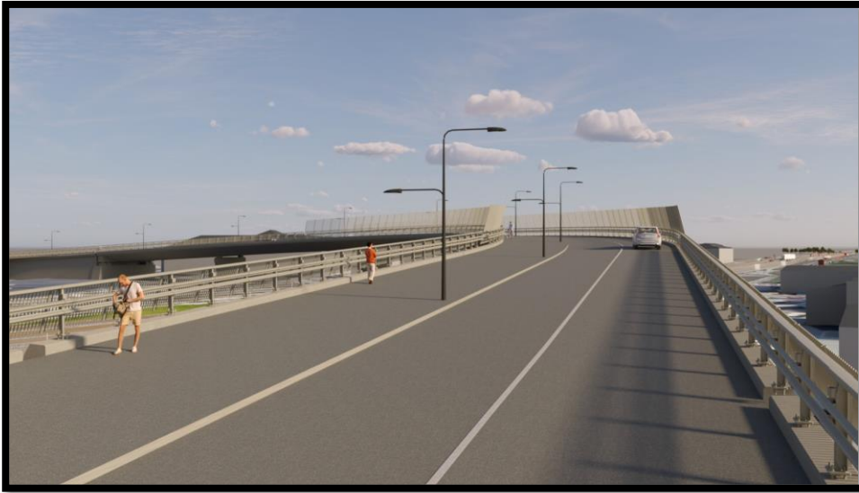
Figur 8-10. Vy 6. Utblick över ny betongbro, med förslag på snedställda skyddsräcken och belysningsarmatur (Sweco, 2025a).
