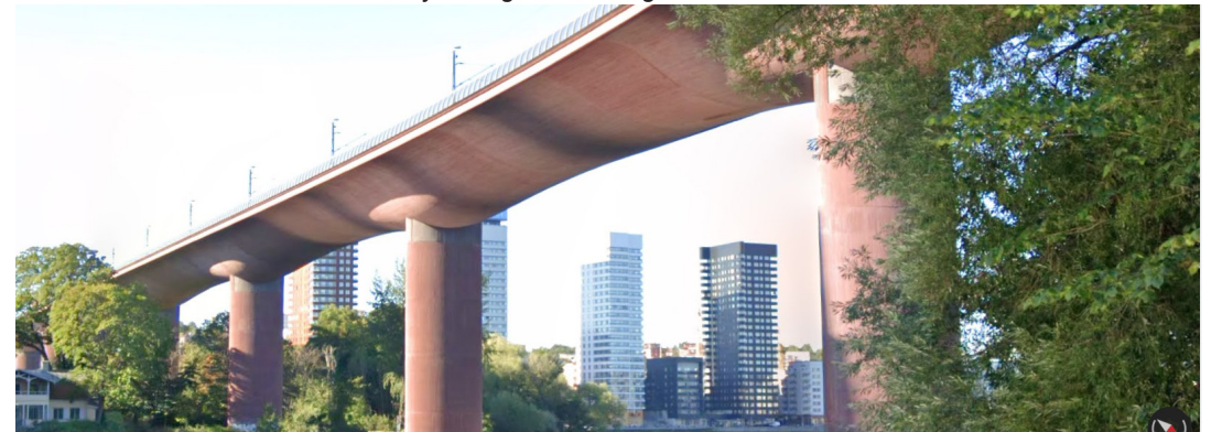
Årsta bron i Stockholm. Betongbron har givits en röd kulör.
