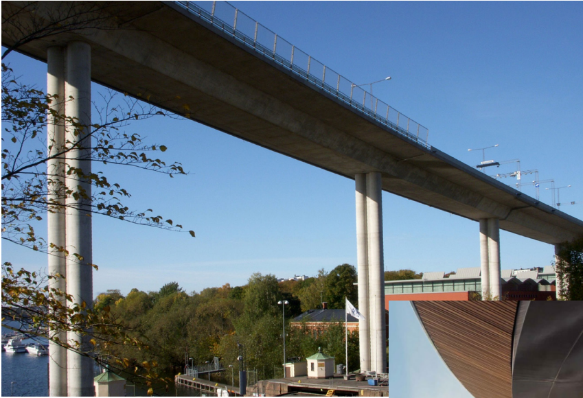
Johanneshovsbron i Stockholm. Bilden till höger visar inklädnad med trä. Bro i Nederländerna
