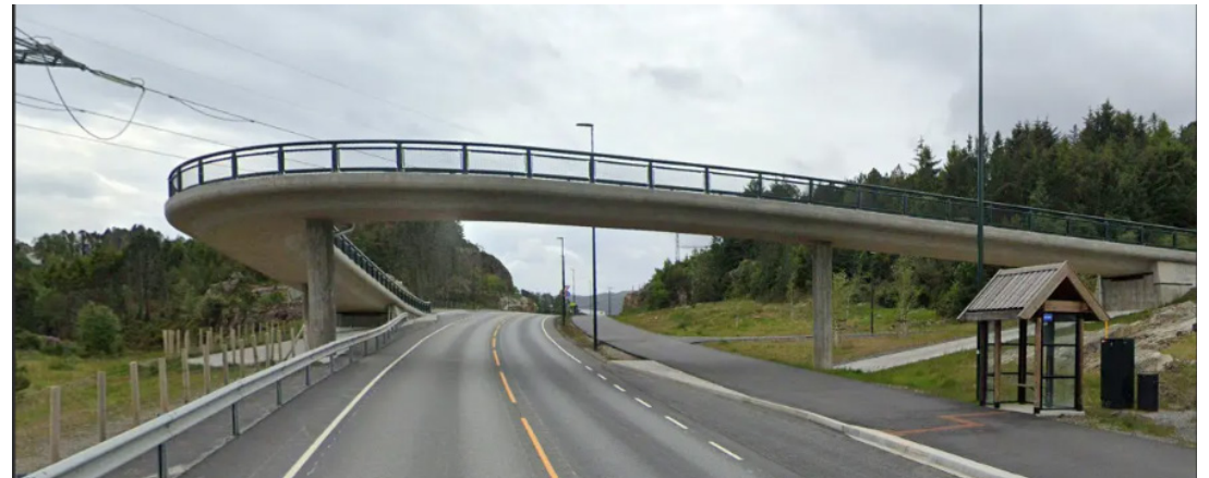
Utblick mot en bågformad betongbro med smäckra brostöd.
