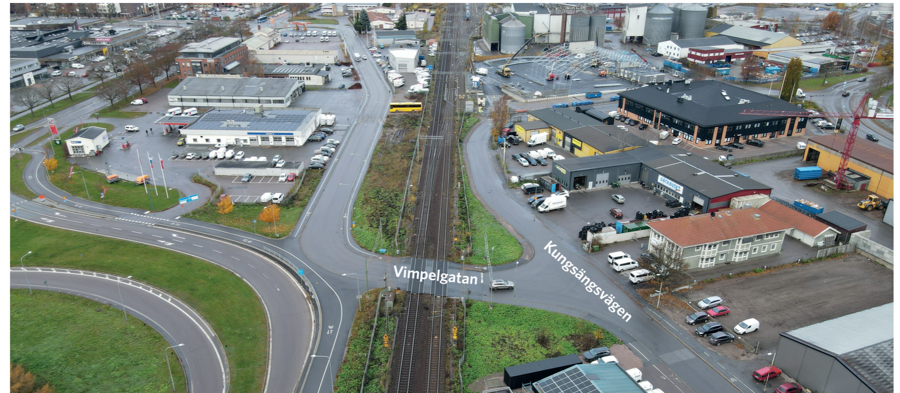
Figur 2. Drönbild över befintlig plankorsning Vimpelgatan - järnvägen.
