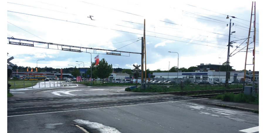
Figur 3. Befintlig plankorsning för tåg på Vimpelgatan som byggs om till planskild förbindelse över järnvägen.
