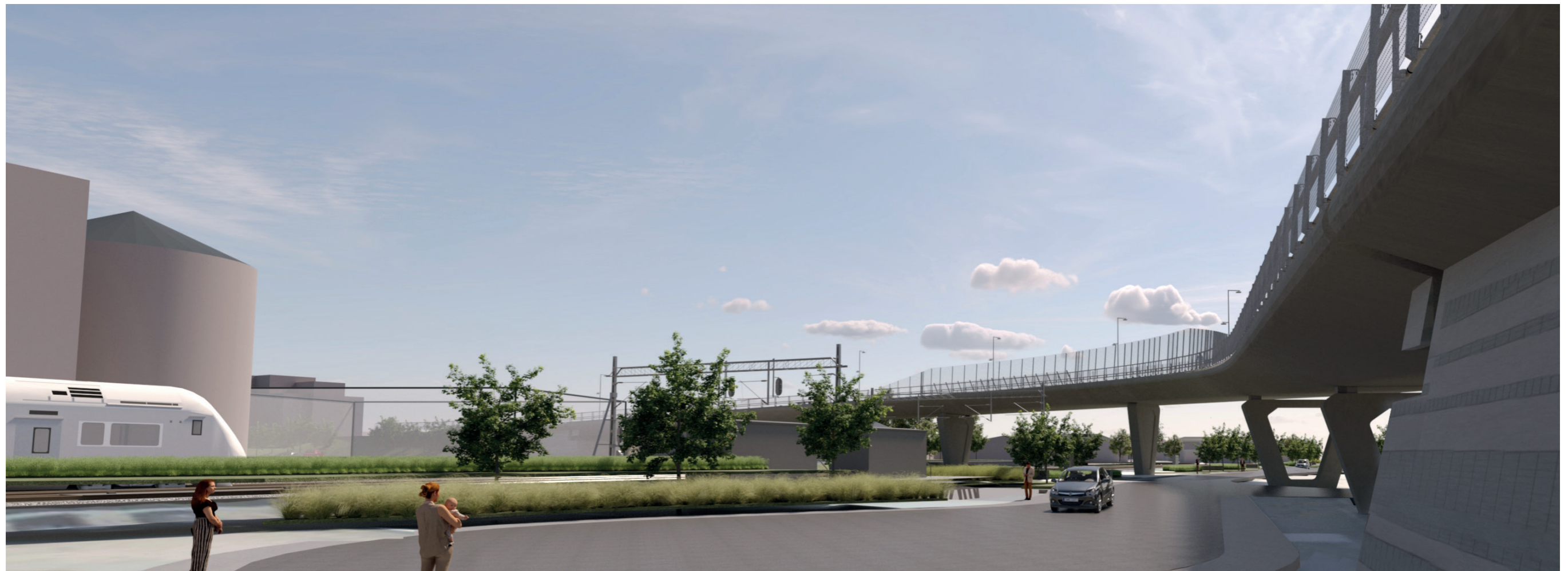
Figur 13. Visualisering av mötet mellan bro, teknikbyggnader, järnväg och väg under bron, med vyn tagen från östra sidan av spåren. I förgrunden syns förslag på beklädnad på stödmur. Brons kantbalk och stödmurens krönbalk har samma form. Se exakt placering av vy i bild till höger ovanför denna visualisering.
