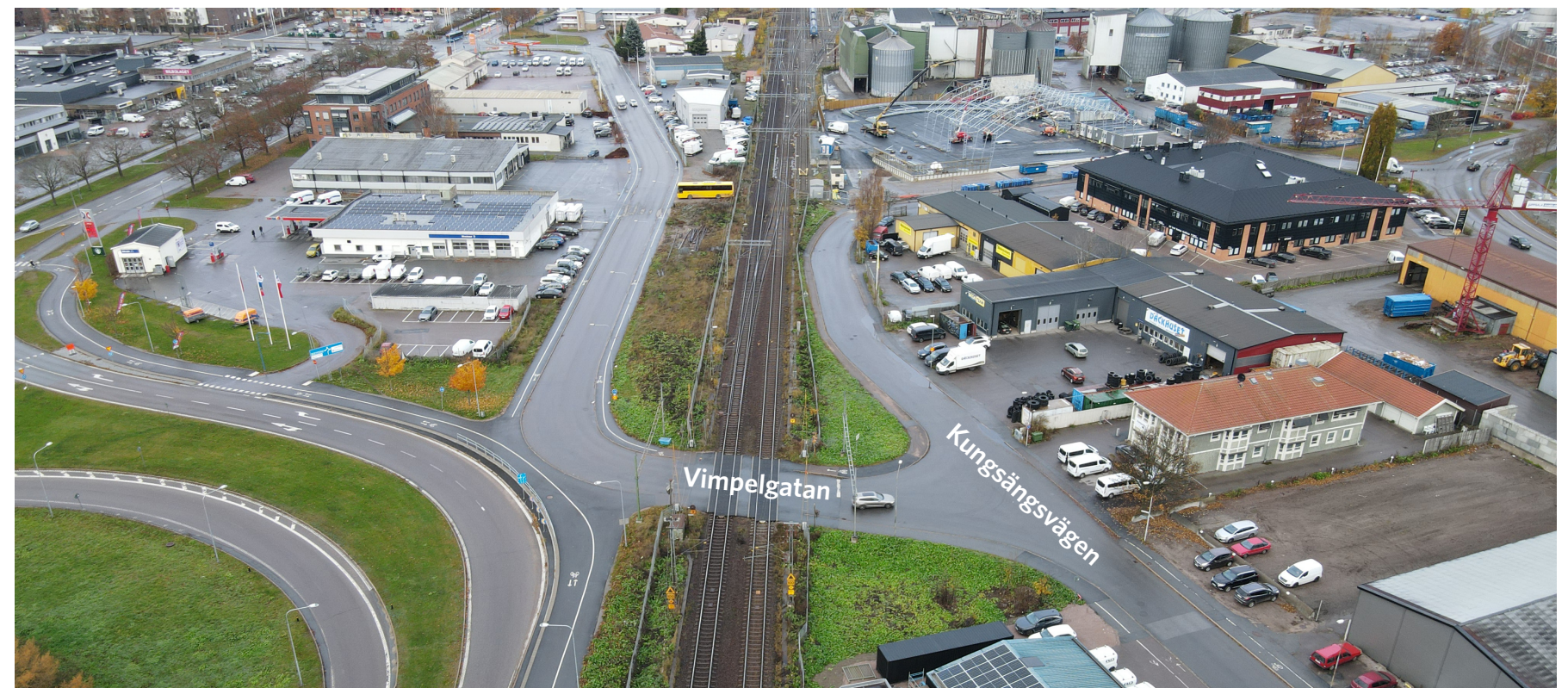
Figur 2. Drönbild över befintlig plankorsning Vimpelgatan - järnvägen.
