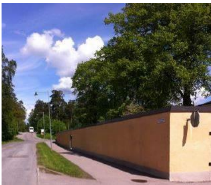
Figur 4.5.8. Ulleråkersvägen vy mot norr
