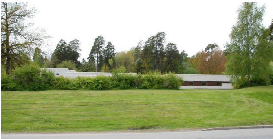
Figur 4.5.4 Neurologiskt centrum (hus nr 78) vy från Ulleråkersvägen innan rivning 2016.
