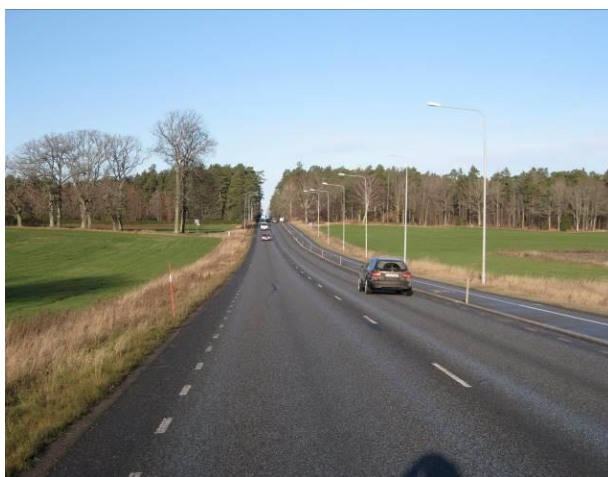
Figur 2.4.11. Vy mot Ulleråker från söder
