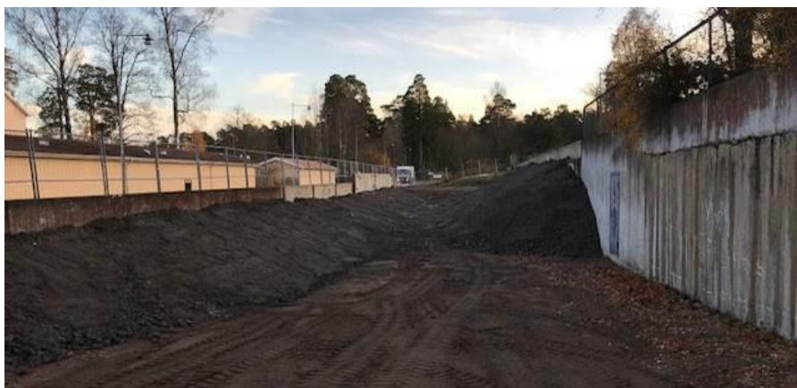
Figur 4.5.7 Sopstation invid Ulleråkersvägen (hus nr 76) efter rivning
