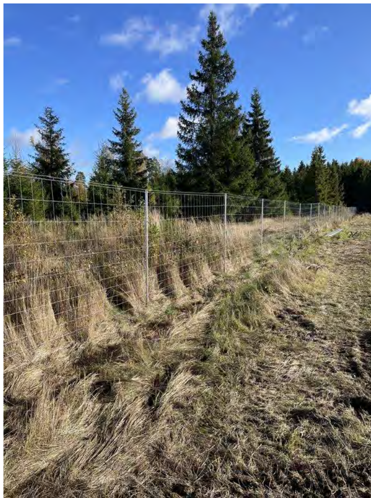
Figur 12-Exempel på stängsel i Helios projekt Kungsåra, Västerås.
