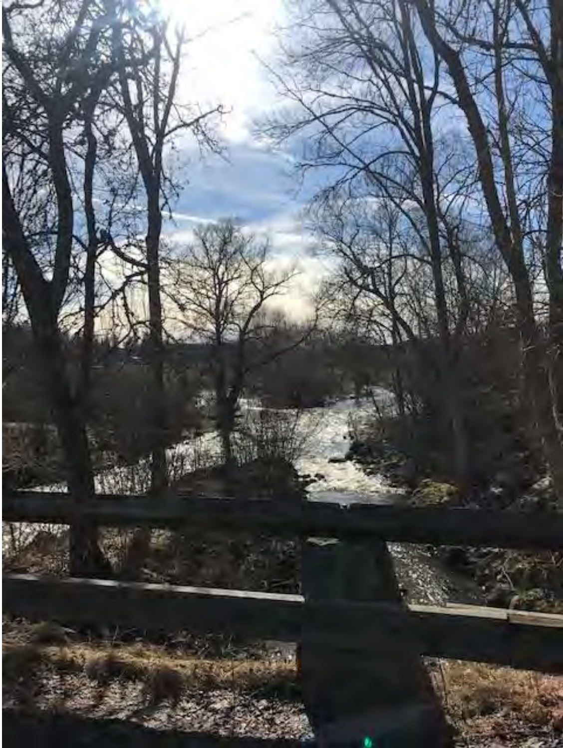
Figur 58-Från stenvalsbron riktning söderut. Helios Nordic Energy AB platsbesök 2023-03-20.
