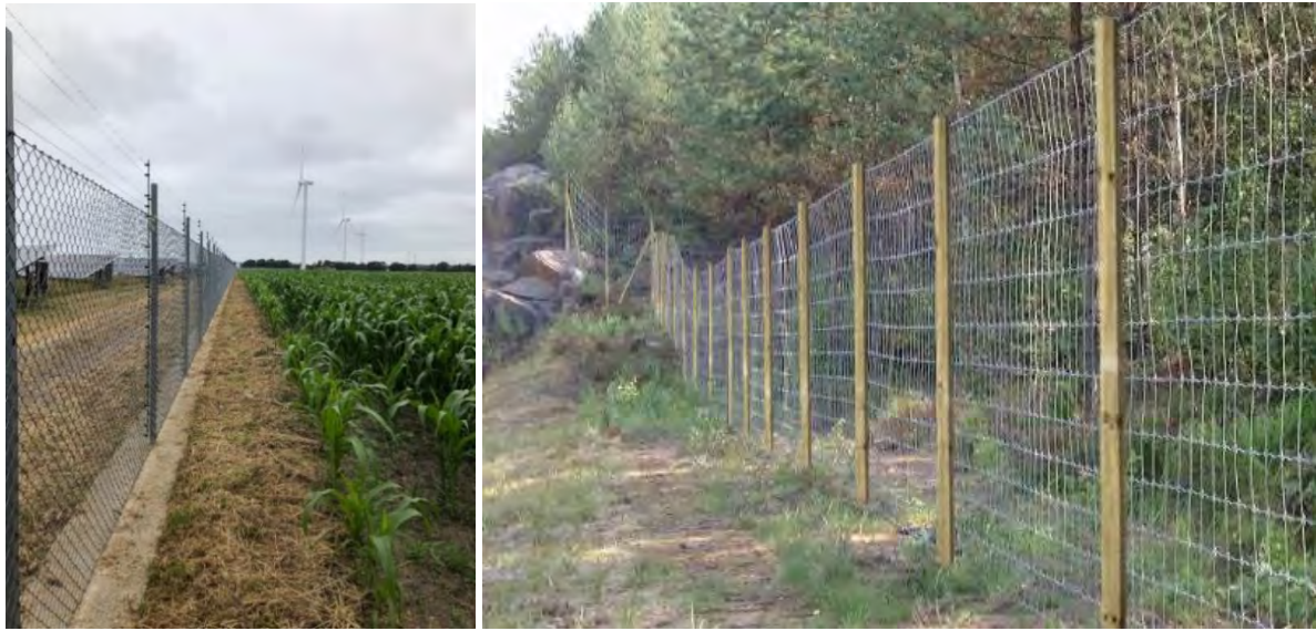
Figur 11-Exempel på utförande av industristängsel med invändigt överklättringsskydd i form av eltrådar (vänster). Exempel på viltstängsel på trästolpar och utan överklättringsskydd (höger).
