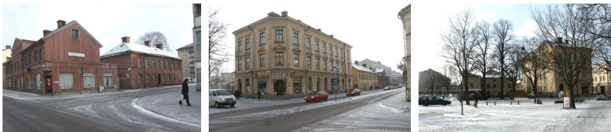
Befintlig bebyggelse i kv Gerd från kv Tor, kv Njord och Vaksala torg. Foto: Stadsbyggnadskontoret.
