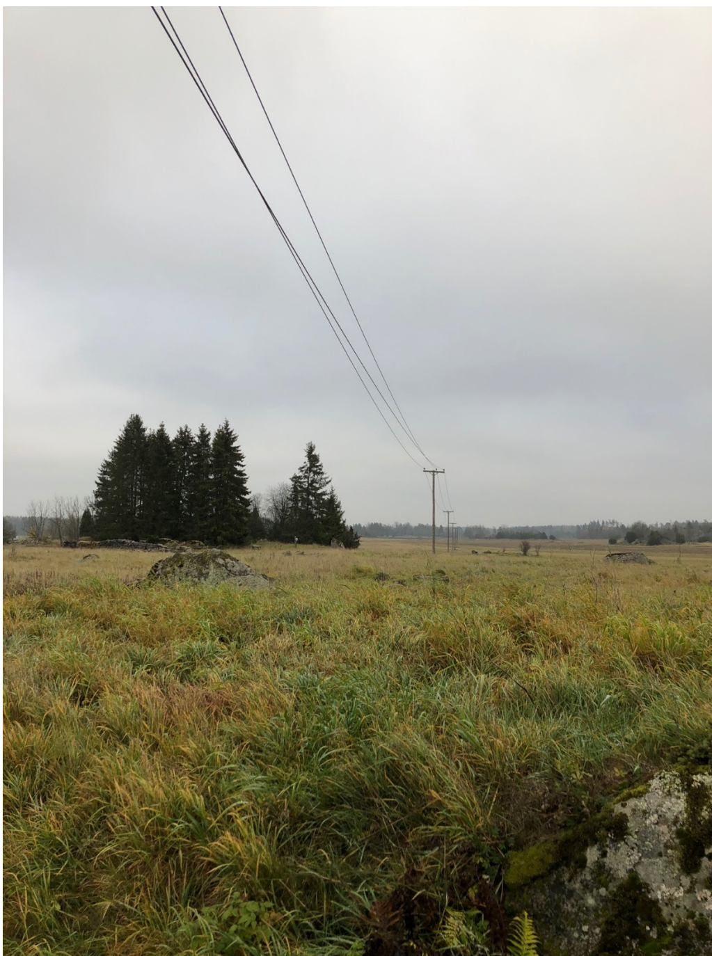
Figur 1. Den stolptyp som företrädesvis kommer att användas är låga enbenta trästolpar med tre horisonellt placerade linor.
