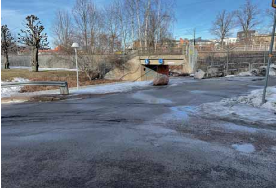
Figur 16 Anslutande gång- och cykelstråk mot Skolgatan.
