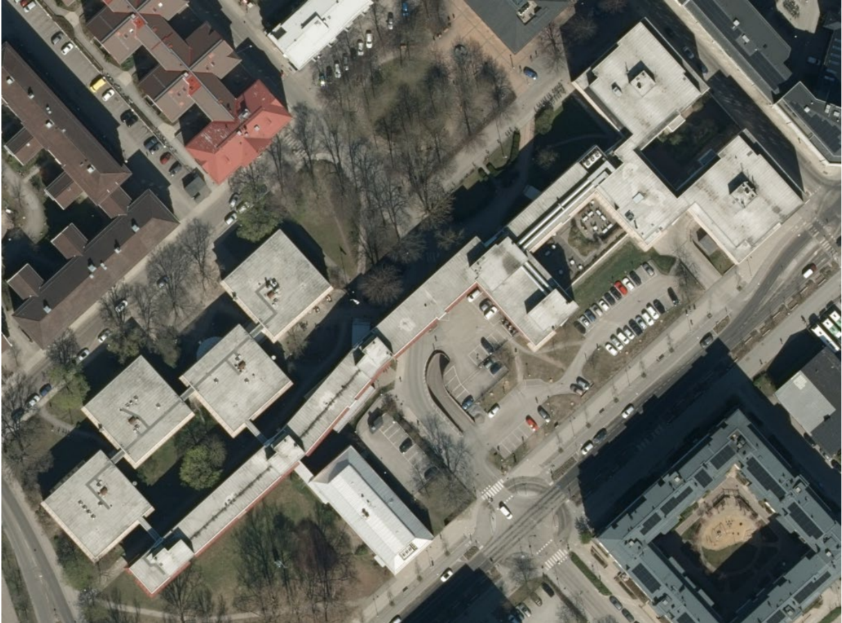
Flygfoto över byggnaderna inom kvarteret Hugin idag.
