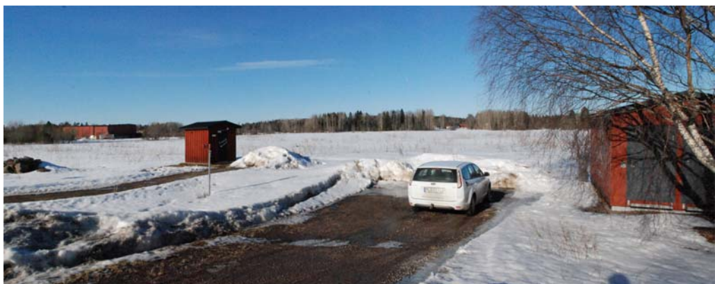
Den västra delen av planområdet är bebyggd med två mindre byggnader för tekniska anläggningar.
