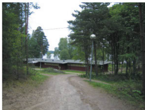
Servicebyggnaden - bakifrån med utsikt över Långsjön.
