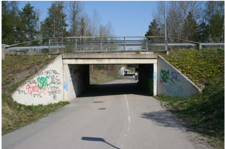
Nuvarande gång- och cykeltunnel vid Hugo Alfvéns väg.
