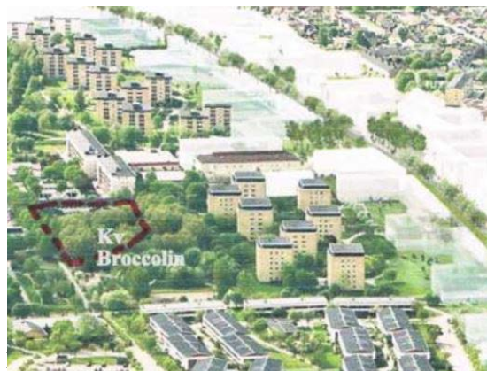
Östra Sala backe. Sett från norr.
