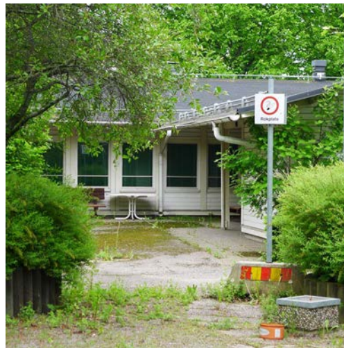
Befintlig byggnad och innergård.
