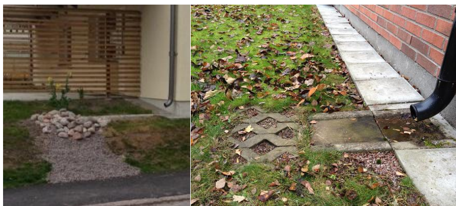
Figur 5. Utkastare med erosionsskydd/infiltration.
