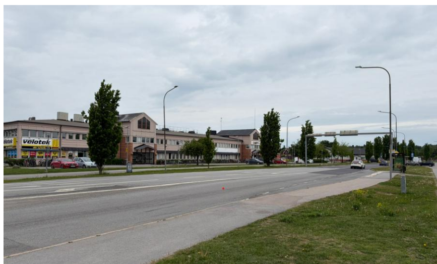
Figur 3 Befintlig byggnad inom kvarteret Löten.
