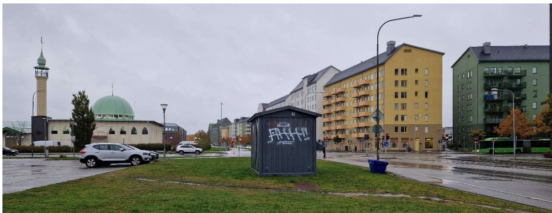
Figur 18. Grå byggnad ligger utanför planområdesgränsen. Byggnadens funktion är okänd.
