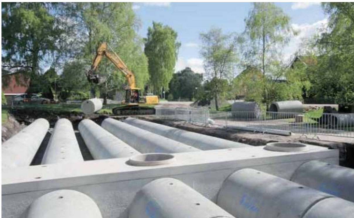
Figur 25. Ett rörmagasin i betong. Magasinet utgörs av parallella ledningar. Bild hämtat från Alfa rör (2007).
