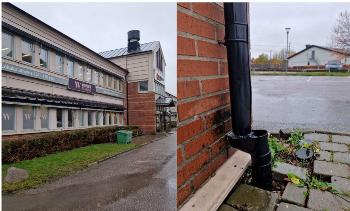
Figur 17. Befintlig byggnads tak avvattnar via stuprör som troligen ansluter mot ledning i mark. Det är oklart om ledningarna ansluter mot exempelvis ett underjordiskt krossmagasin eller ansluter direkt mot kommunalt ledningsnät för dagvatten. Planteringar som delvis omgärdar byggnaden förefaller inte omhändertaga något takdagvatten.
