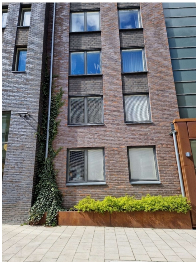
Figur 23. Upphöjda regnväxtbäddar längs med fasad för omhändertagande av takdagvatten. Ev. mynnar ett par utvändigt dragna stuprör i regnväxtbädden. Bild från Norra Djurgårdsstaden (Bjerking).
