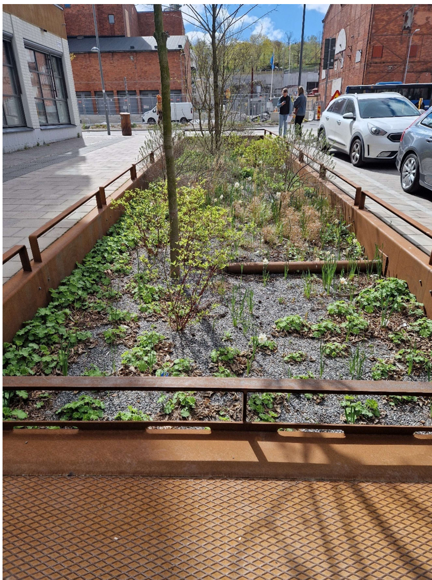
Figur 24. Nedsänkt dagvattenanläggning/regnväxtbädd med djup ytlig svämzon. Översta lagret utgörs av finare grus utan nollfraktion. Bild från Norra Djurgårdsstaden (Bjerking).
